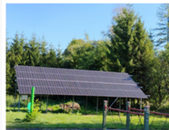
Ochotnicza Straż Pożarna w Nadolanach zamontowała panele o mocy 8,925 kWp.
