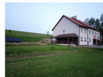
Ochotnicza Straż Pożarna w Zboiskach zamontowała panele o mocy 2,58 kWp.
