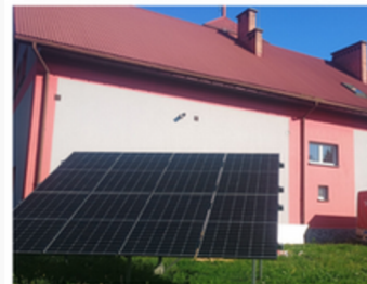
Ochotnicza Straż Pożarna w Bukowsku zamontowała panele o mocy 3,32 kWp.
