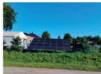
Ochotnicza Straż Pożarna w Nagórzanach zamontowała panele o mocy 6,3 kWp.
