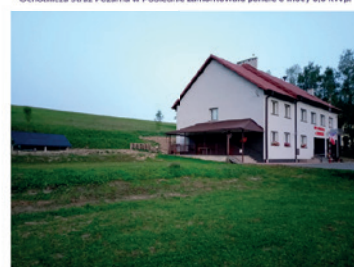
Ochotnicza Straż Pożarna w Zboiskach zamontowała panele o mocy 2,59 kWp.
